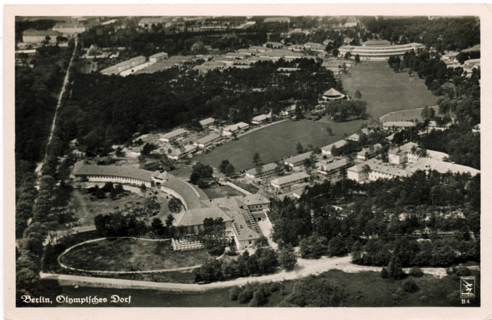
Blick nach Westen (hier sind oben links Gebäude der Adler-Kaserne erkennbar).
