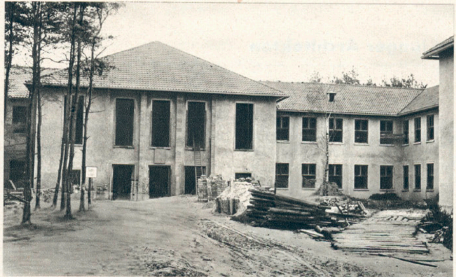
Das seiner Vollendung entgegengehende Gemeinschaftshaus. Zukünftiger Festhof und Mittelbau mit Haupteingang
