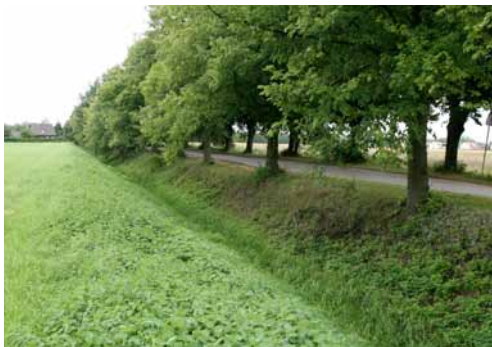
2011; der höher liegende Rohrbecker Damm Richtung Finkenkrug ist Teil des alten Damms durch das Luch.
