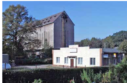
2000; Weiteres Speichergebäude, errichtet für das Heeresproviantamt, zwischen Hauptstraße und Bahnstrecke gelegen. Rechts davor die ehemalige Emaille-Schilder-Fabrik von Hermann Bräuer (etwa 1934), zu DDR-Zeiten Betrieb für Bautenschutz. Heute Hauptstraße 29.
