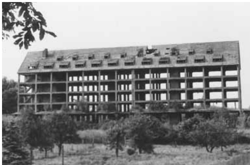
1985; Ehemaliger Versorgungsspeicher des Heeresproviantamtes, Ende der 1930er Jahre an der Bahnstrecke errichtet.
