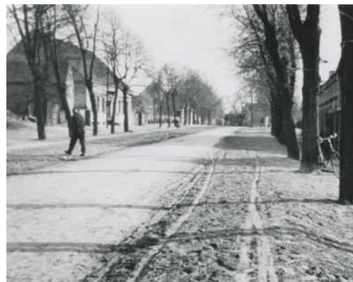
Um 1940; Rohrbeck. Ansicht der Dorfstraße mit Blick nach Süden.
