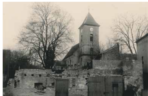
1970; Mauerreste des abgebrochenen „Spritzenhauses“.
